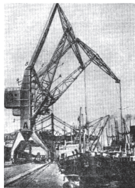
Фиг.22 Кампнагел 12т.40м. с елипсограф
