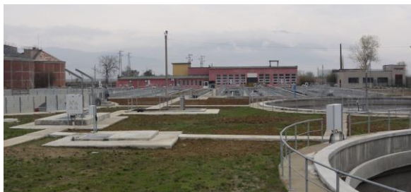
Фиг. 1 ПСОВ Кюстендил след реконструкция
