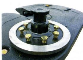
Фиг. 6. Централен болт със фланец
