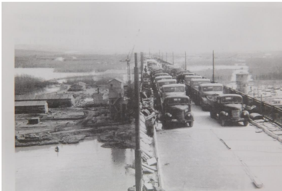
Фиг. 10. Пробно натоварване.
