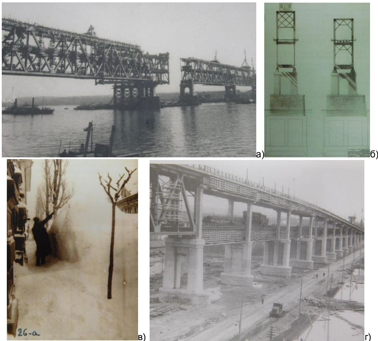
Фиг. 4. Работни дейности по моста (а); б) разрез на стоманените ферми при опората; в) зима-1952/53г; г) завършените виадукти.
