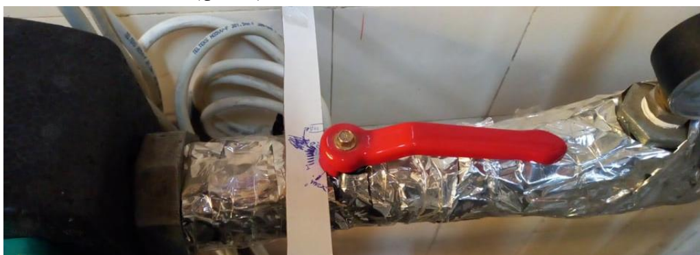
Фиг. 4. Вентил за регулиране на дебита на флуида, течащ във вътрешния кръг на инсталацията
