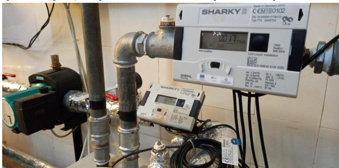
Фиг. 2. Топломери в двата кръга на инсталацията
