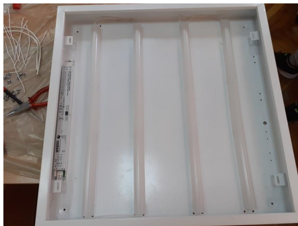
Фиг. 6. Завършеният осветител с монтирани разсейватели
