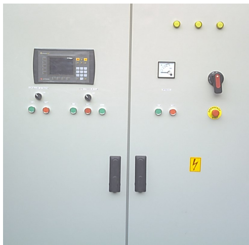
Фиг.2 Външен вид на ел. шкаф за управление на фуражен цех
