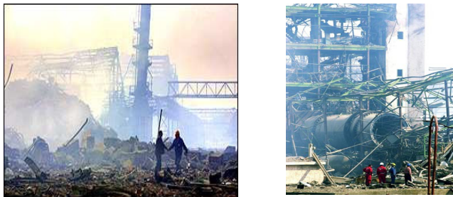
Фиг. 5. Поражения от взрива в завод AZF за торове в Тулуза, Франция
