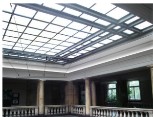
1-e. Решетъчната конструкция, подготвена за реконструкция.
