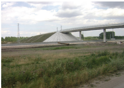
Снимка №1 Изграждане на надлез [4]
