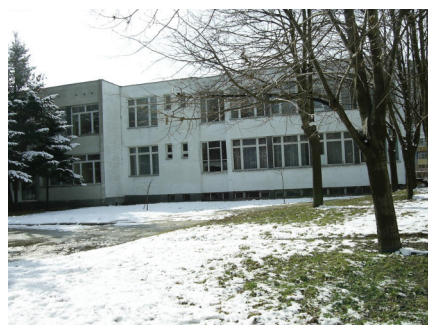
Фиг.5. Общ вид на сградата на корпус 10
