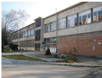
Фиг.2. Общ вид на сградата на корпус 3
