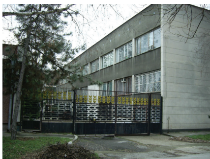
Фиг.4. Общ вид на сградата на корпус 8
