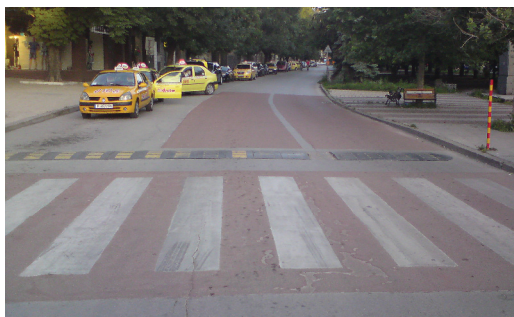
Фиг. 1. Настилка с висок коефициент на сцепление по бул „Цар Освободител“, гр. Русе.
