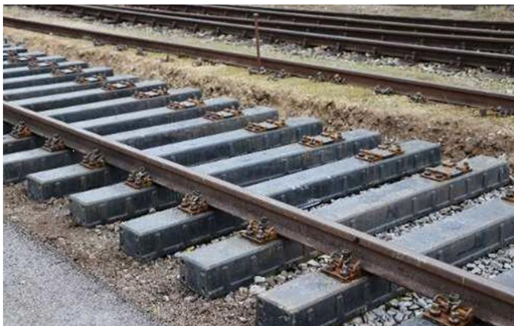
Фиг. 8. Проектираната полимерна траверса
