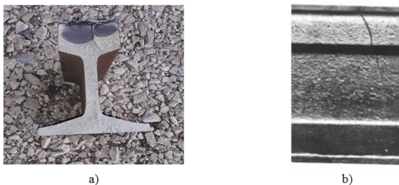
Фиг. 3. Напречни дефекти: (а) пукнатина в глава релса; б) страничен изглед
