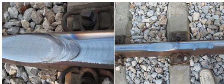
Фиг. 5. Дефекти на релси при деформация от колело.
