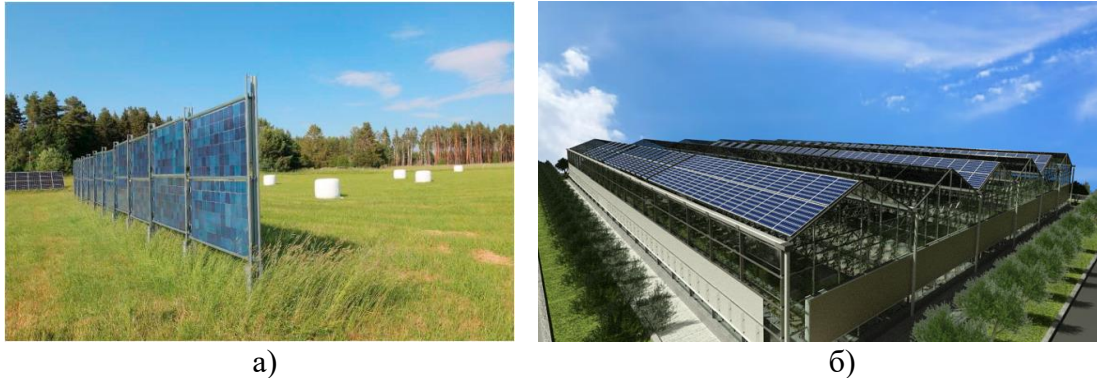
Фиг. 2. Примери за вертикални (Campana et al, 2021) и хоризонтални (Torrente et al, 2024) агро-фотоволтаични инсталации
