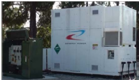
Фиг. 2. Общ вид на свръхпроводников токоограничаващ реактор с насищащо се ядро [9]
