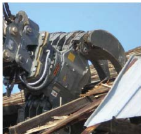
Фиг. 2. Грайфер за разрушаване на фирма Kinshofer.
