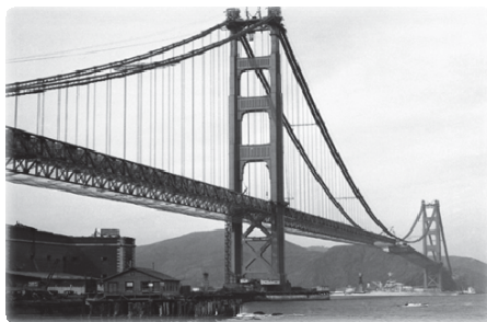
Фиг.6. Последен етап на строежа
