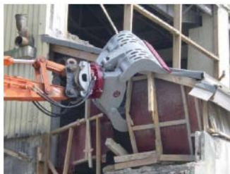
Фиг. 3. Грайфер за разрушаване на фирма Demarec.
